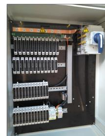
Figura 9 CcM-Shunt ejemplo de instalación
